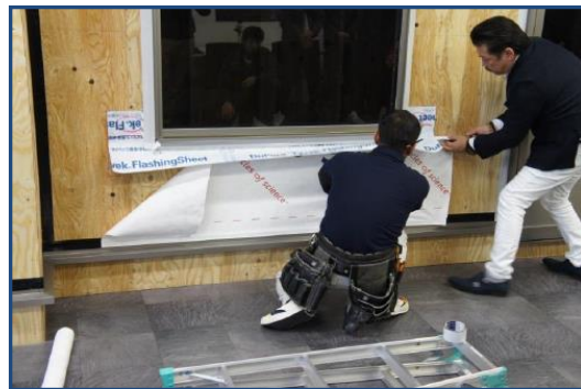
模擬棟を使い、防水紙の施工手順や施工のポイントを実際に目で見て、体験することができます。
