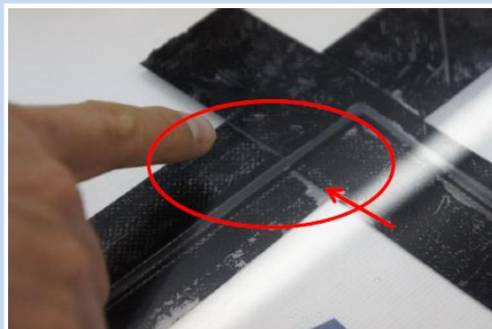
アクリル板の裏から防水テープの接着状況について確認。張り方によっては、水みちができてしまう場合もある。
